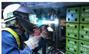
橋脚のアンカー補修工事
