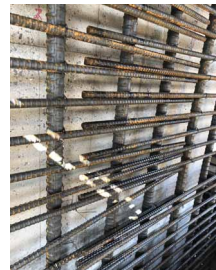
帯鉄筋の重ね継手を突合せ溶接に変更して工期短縮
