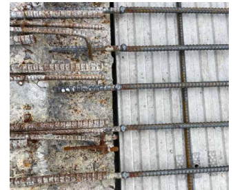
拡幅工事継手施工後
