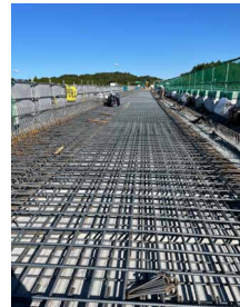
高速道路拡幅工事全景
