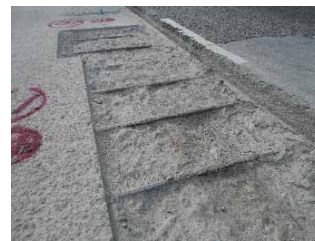
ブレーカーによるはつり面 オートチッパーによるはつり面
