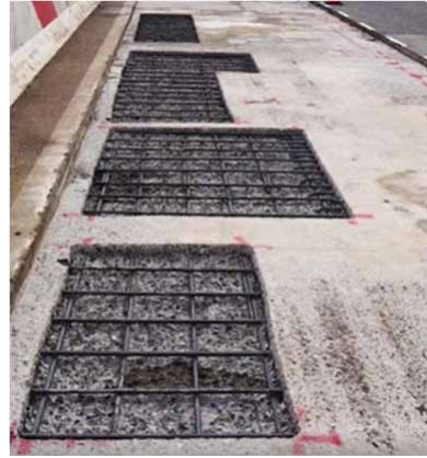
本工法によるはつり作業を行ったコンクリート床版
