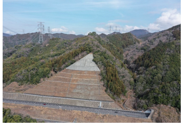
ファーストクリート工法
