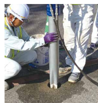
打込機によるスリーブパイルの打設
