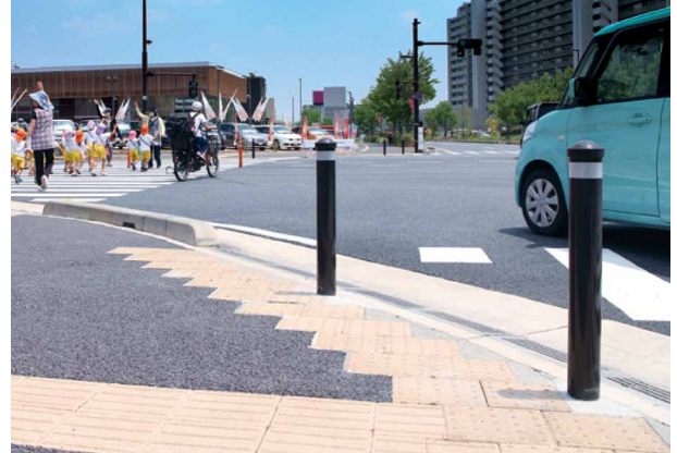
施工例（さいたま市緑区）
