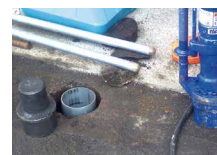
スリーブパイル設置完了
