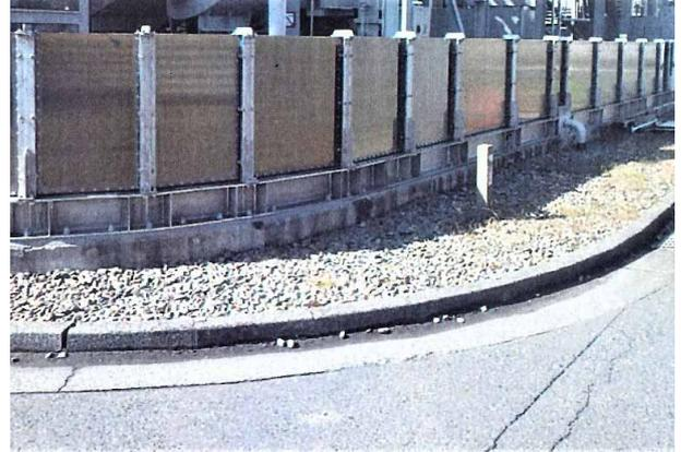
金属製止水壁（屋外の設備を守る）
