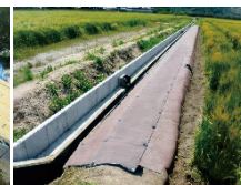
農業 遊歩道と排水路補強
