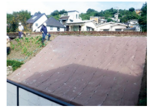
④散水養生
