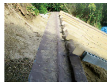
法面 小段排水工
