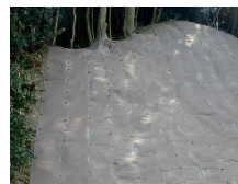
鉄道沿 法面保護工
