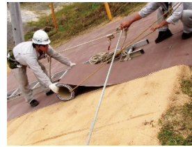
③ドライマット敷設
