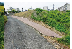
道路沿 法面保護と防草
