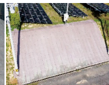
太陽光 法面保護工
