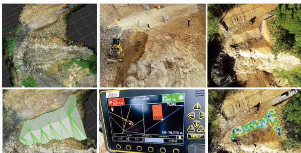
1. UAV着工前～3D設計データ 2. ICT法面掘削機掘削・整形 3. 完了～UAV出来形～3D出来形評価 3Dシミュレーションを活用した出来形確認
