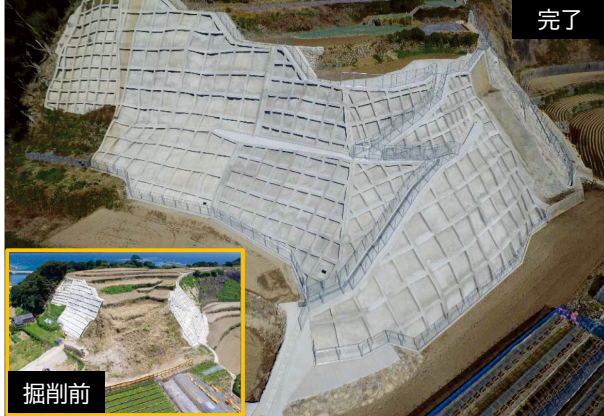
ICT技術を活用した施工事例
