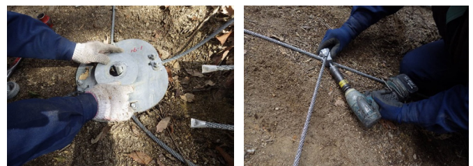
押さえパイプ設置状況
