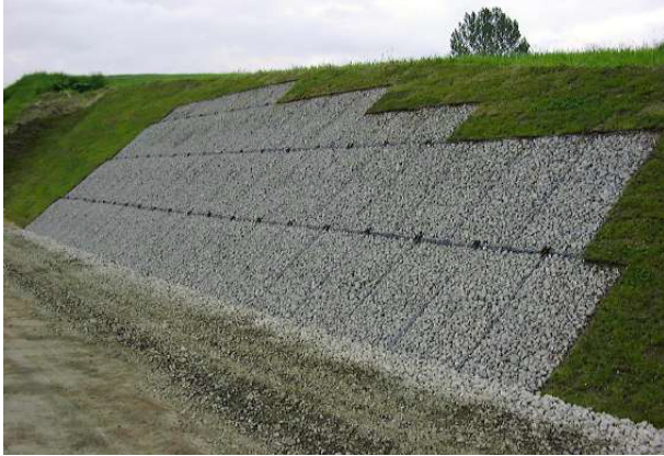
施工状況（法面保護）
