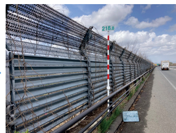
施工後(2022年6月30日)
