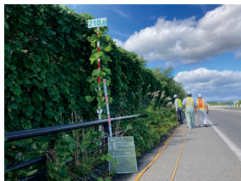
施工前(施工日:2021年9月14日)
