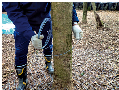
②立木の周辺を囲むようにネットを張設し、ネットの網目をくぐらせながらリングを取り付ける。
