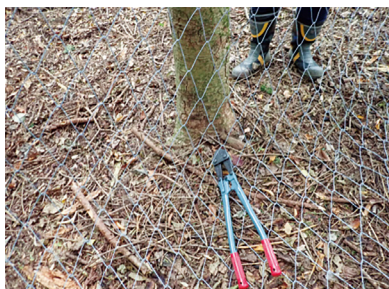
①デルタックスネットを地表面に張設し、立木通過部でネットを切断する。
