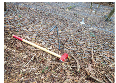
③リングにクリップを取り付けて固定し、200㎡につき1カ所アンカーピンを打設して固定する。
