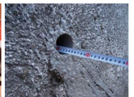
空隙状況確認
