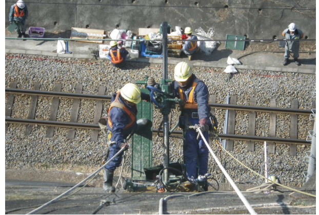
施工事例：軌道上での調査
