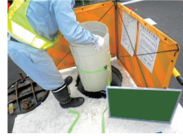
MLRモールド設置状況
