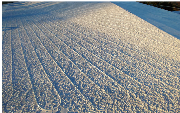
オンリーワン タイプF 施工例 (Snow Peak FIELD SUITE SPA HEADQUARTERS)
