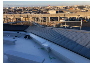
施工完了 (本館屋根)
