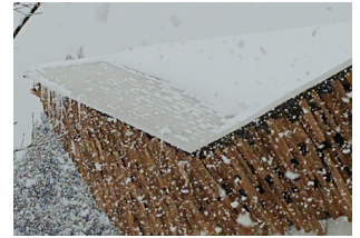
施工箇所は、問題なく雪が溶けているのが分かる
