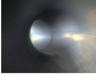
KU-LINER®工法の仕上がり内面 (曲管部22.5°)
