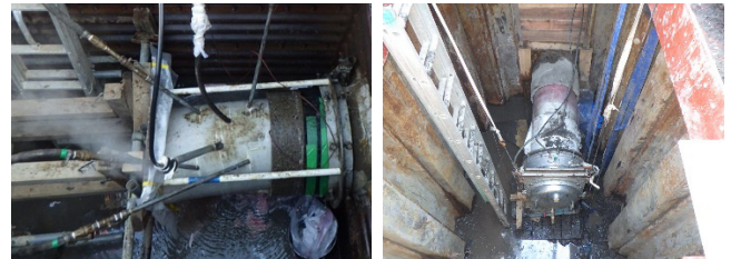
加熱養生の様子
