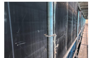
SA-411（躯体面：後やり防水）
