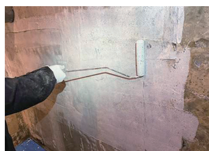
①HSプライマー塗布
