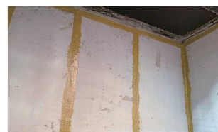
④接合部へのサンエーボンドE40塗布 ※汚水槽仕様の場合
