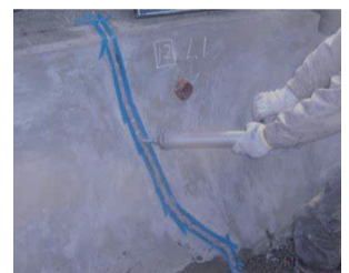
ひび割れへの施工状況
