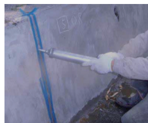
目地への施工状況
