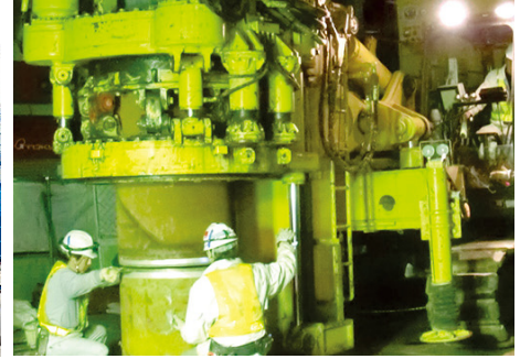
空頭制限・狭隘部での施工事例
