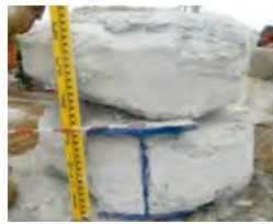
H-300×300(SRC)切断撤去
