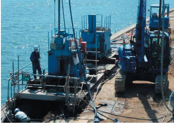
PJG工法 施工状況
