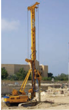
BG工法 (多目的機械掘削工法)
