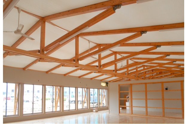
施工例：茨城県 公共施設
