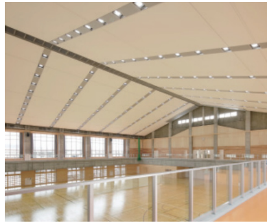
静岡県 総合体育館
