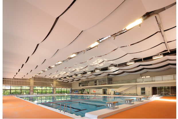
膜天井施工後
