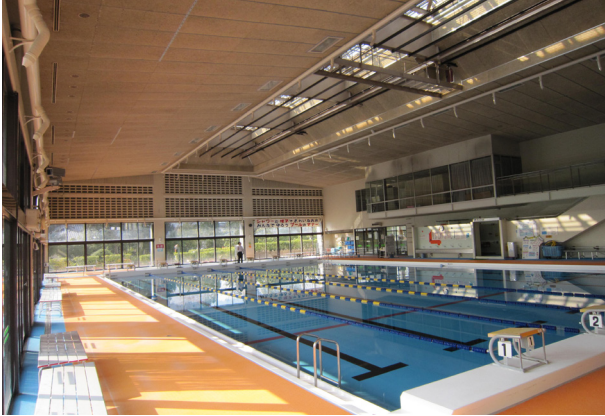
膜天井施工前
