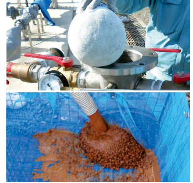
アクアピグ工法による水道管内洗浄
