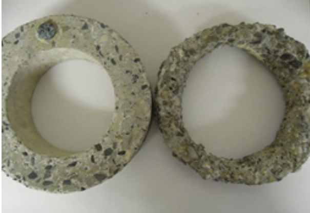
腐食状況比較 (左: ビックリート 右: 普通コンクリート)
