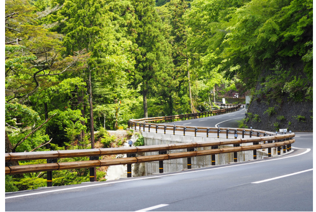
施工事例（道路改良工事）
