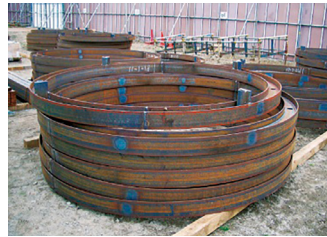
鉄筋籠/補強リング
