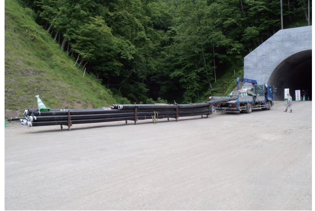
施工例 (トンネル消火設備配管)
