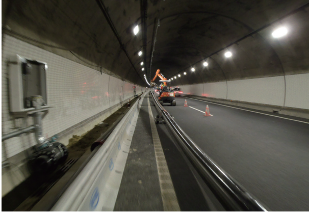
施工例 (トンネル消火設備配管)
