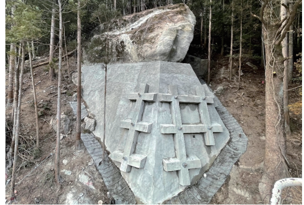
転石一体化根固め工法の施工事例 (推定重量約1400t)
