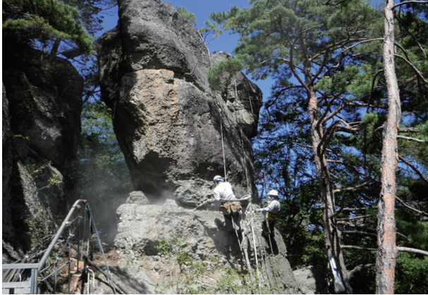
根固め工・岩盤接着工の施工事例
