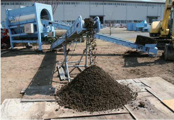
リサイクルアースグリーン工法（発生土ふるい分け状況）
