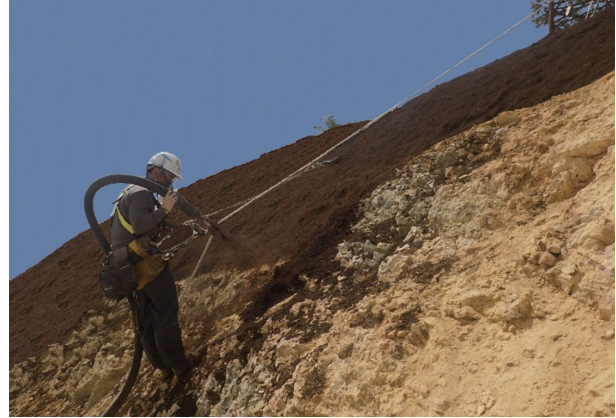
ノンラスグリーン工法（施工状況）
