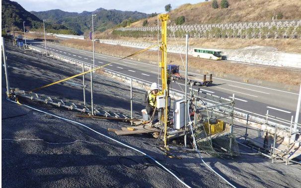
高速道路のり面調査状況
