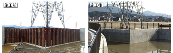
新設鋼矢板の防食（調整池）
