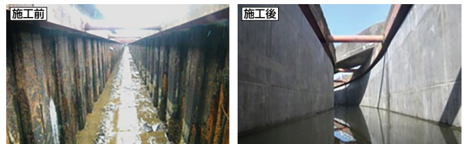
新設鋼矢板の防食（調整池）
