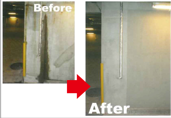
施工前・施工後
