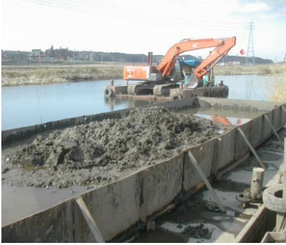
①河川での浚渫作業
