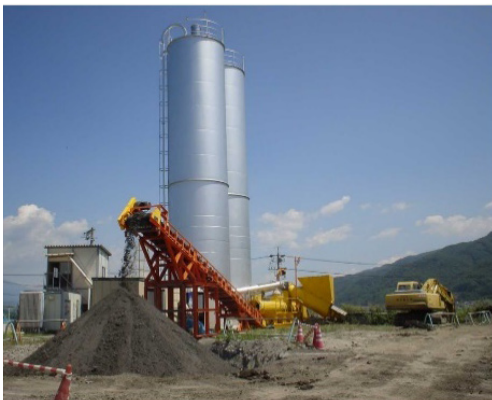
湖の浚渫土の改良 (改質土は傾斜型周景護岸盛土等に利活用)
