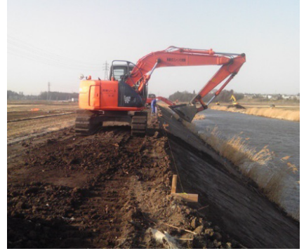
③築堤盛土の施工
