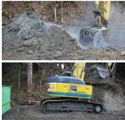
浅層混合改良（仮設施工ヤード） 混合作業と混合直後のバックホウ走行
