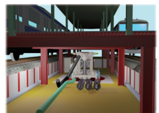
桁式ホーム下での施工
