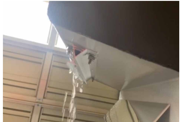
散水試験状況
