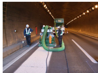
TN ギガショット施工中1列目
