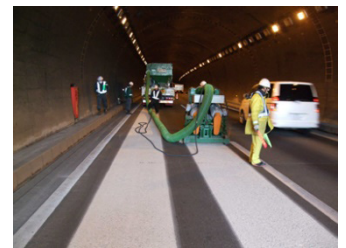
TN ギガショット施工中2列目
