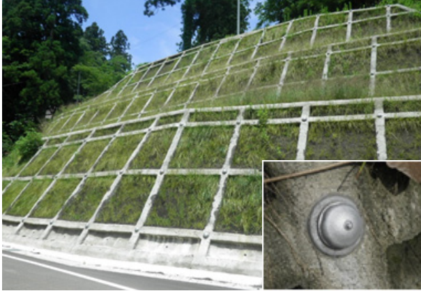
施工事例 現場吹付法枠工
