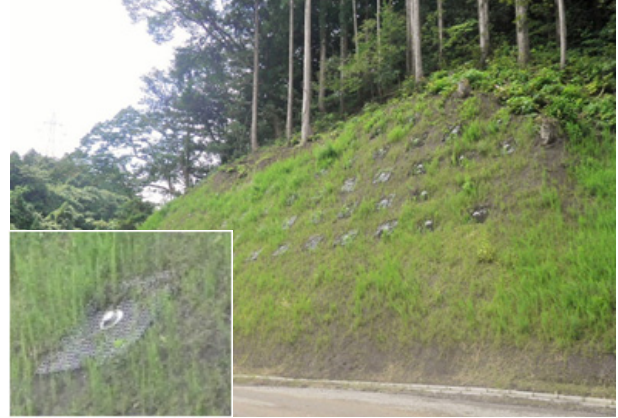
施工事例 グリーンパネル工法
