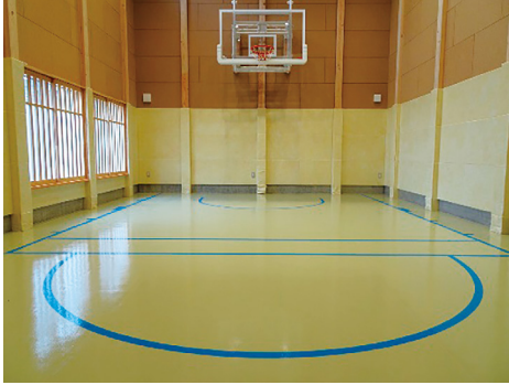
新設施工事例 表層シート+テクセル床工法
