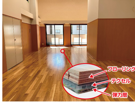
新設施工事例 フローリング+テクセル床工法
