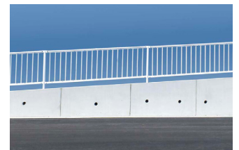
天端勾配製品 (WS) の施工例
