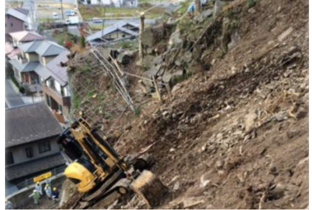
保安林保全緊急対策工
