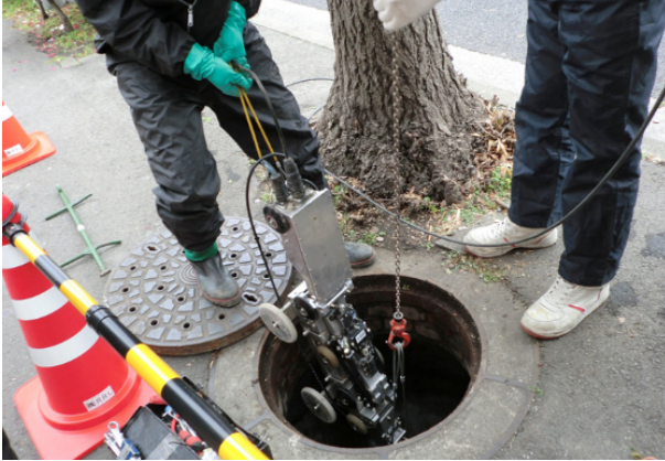
ロボットのマンホール挿入状況
