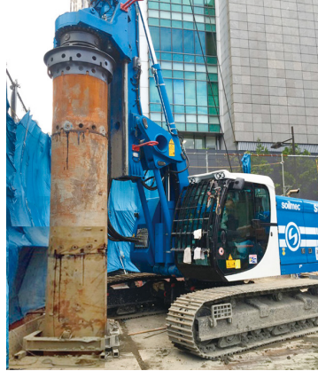
多機能掘削機による場所打ち杭工・地中構造物撤去工
