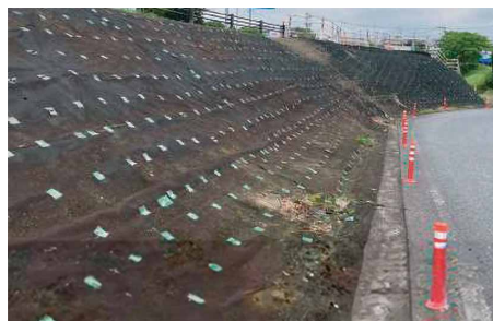
11年経過した道路法面状況
