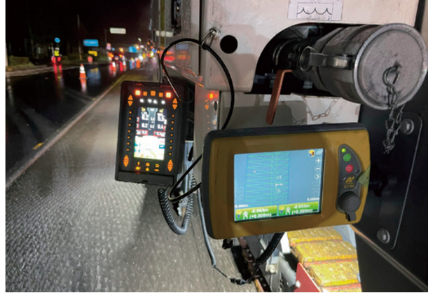
ICT建機を用いた施工状況
