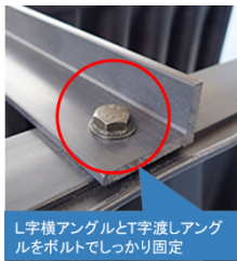
③浮上防止補助アンクルの固定
