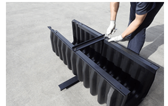
④中央部渡しアンクルの取り付け
