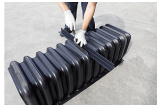
③浮上防止補助アンクルの固定
