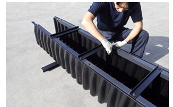
⑥重ね合わせ部渡しアンクルの取り付け
