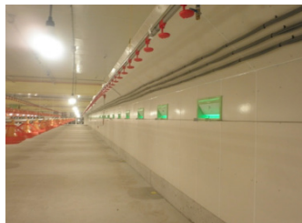
畜舎内装（壁・天井）
