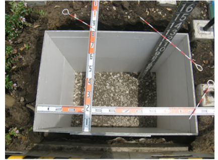
埋設型枠用途現場
