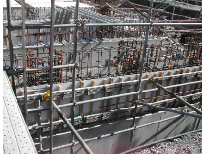
型枠用途現場
