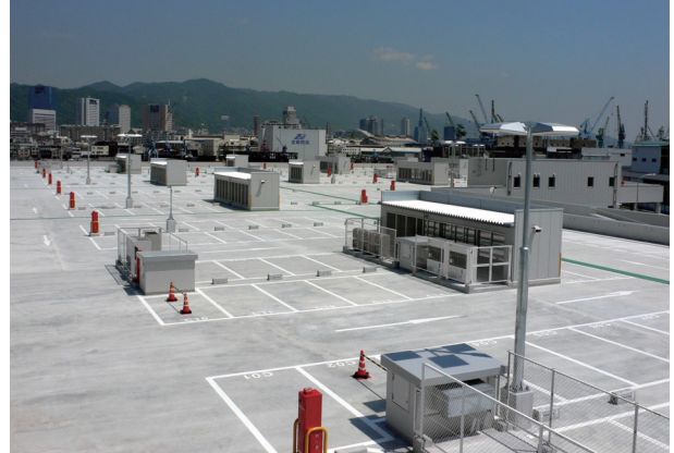
施工例 (屋上駐車場防水/10年保証)
