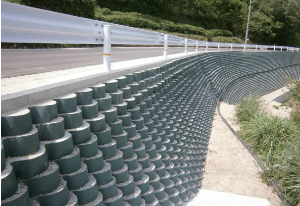
ジオウエップによる擁壁工
