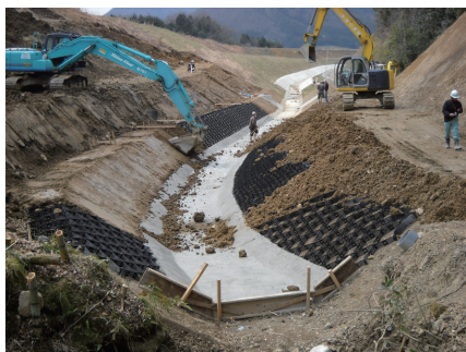
ジオウエップによる水路工
