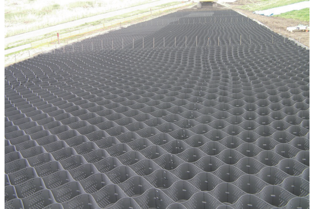
ジオウエップによる路盤工
