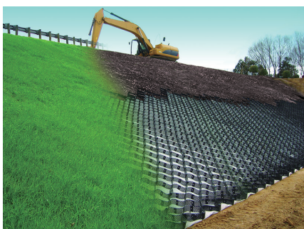
ジオウエップによる法面工
